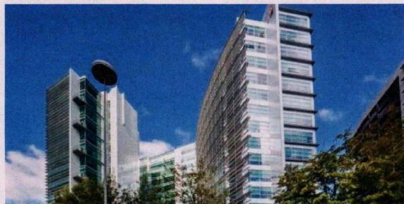
↑ Edifício que foi ocupado pelos Correios voltou a ter ocupação
